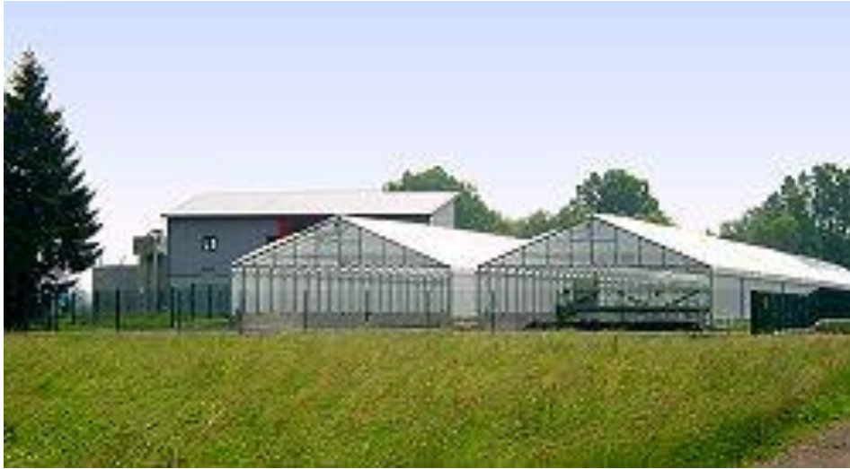
Εικόνα 2.5 «Εγκατάσταση ηλιακής ξήρανσης λυματολάσπης»
