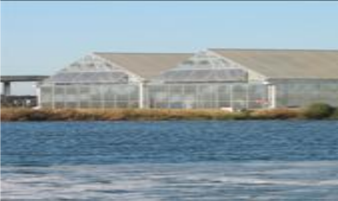
Εικόνα 2.6 «THERMO-SYSTEM Solar Sludge Dryer της Εταιρίας Parkson»
