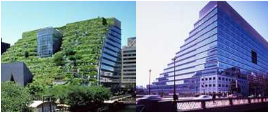
Εικόνα 2.19: Παράδειγμα φυτεμένου δώματος, ACROS Fukuoka Prefectural International Hall (Πηγή: www.greenroofs.gr )
