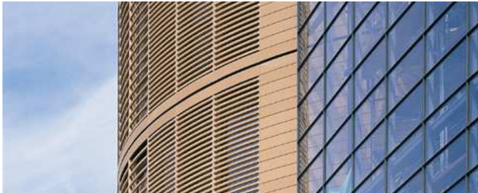
Εικόνα 2.23: Εφαρμογές της αεριζόμενης τοιχοποιίας (Πηγή: www.nbk.de )
