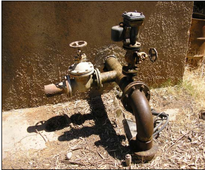
Εικόνα 3.4 & 3.5 Τελική σωλήνωση γεώτρησης & το εσωτερικό δεξαμενής αποθήκευσης
