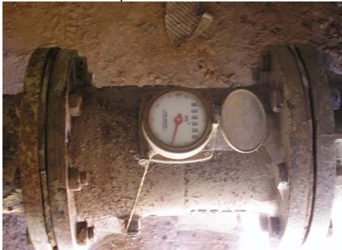
Εικόνα 3.8 Υδρόμετρο γεώτρησης
