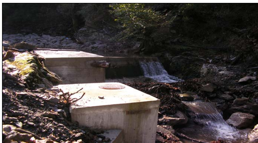
Εικόνα 3.12 Δεξαμενές καθίζησης
