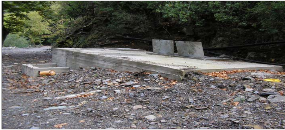
Εικόνα 3.13 Δεξαμενές καθίζησης
