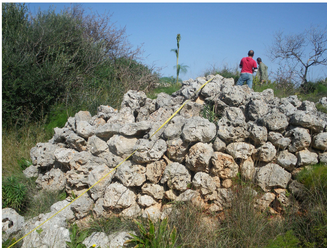
Εικόνα 8.2: Επιφανειακό έγκοιλο στην περιοχή έρευνας.
