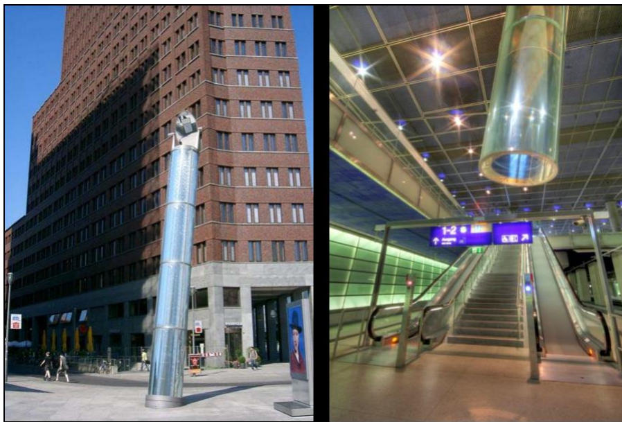
Εικόνα 3.34: Χρήση φωτοσωλήνα σε σταθμό μετρό στη Γερμανία
