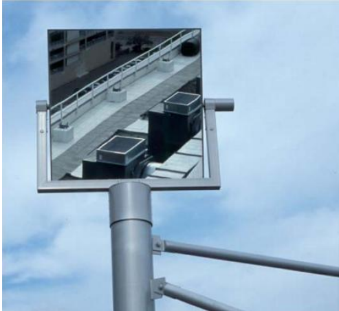
Εικόνα 3.41: Κάτοπτρο ενίσχυσης προσπίπτουσας ηλιακής ακτινοβολίας σε φωτοσωλήνες
