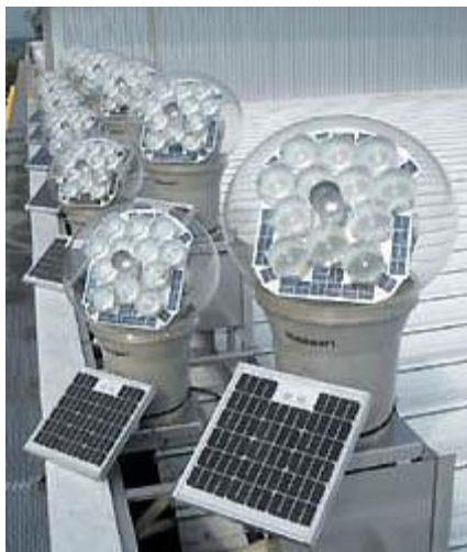
Εικόνα 3.46: Πολλαπλοί συλλέκτες Hiwari σε οροφή κτιρίου
