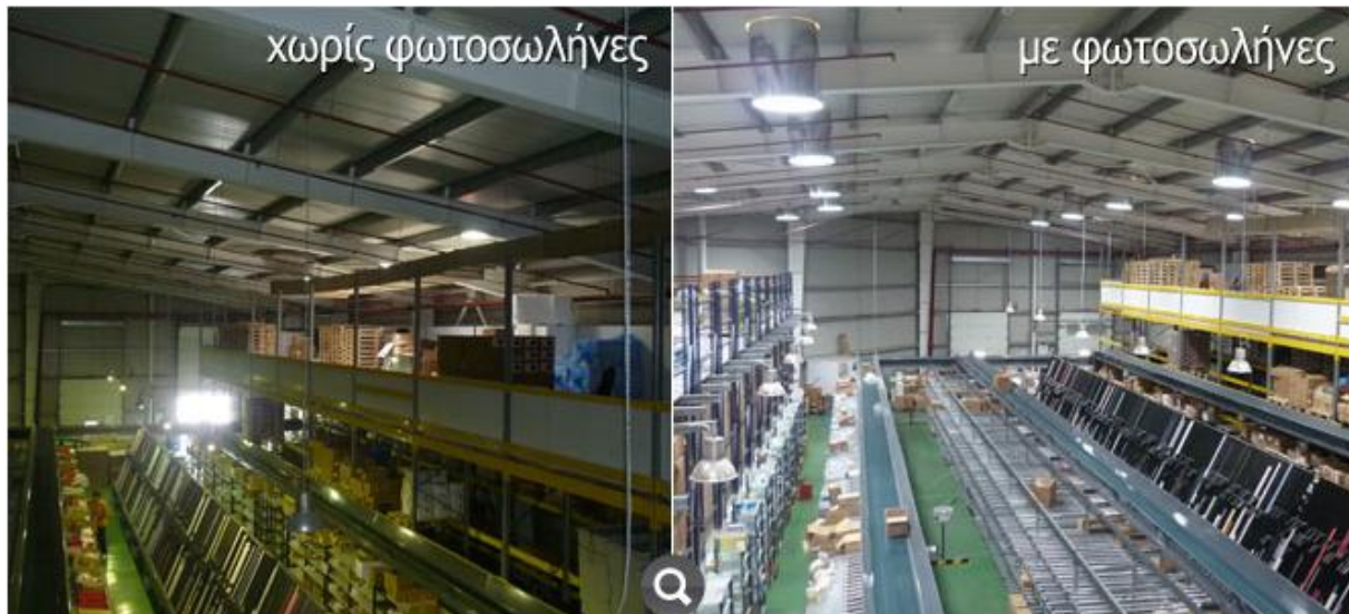
Εικόνα 3.35: Εφαρμογή φωτοσωλήνων σε εργοστάσιο στην Ελλάδα 3
