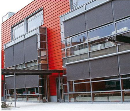
Εικόνα 9.14: Σκίαση κτιρίων με ρολά
