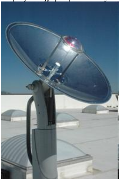
Εικόνα 3.42: α) Συλλογή και β) διάθεση φυσικού φωτός σε κτίριο με σύστημα Sunlight-Direct
