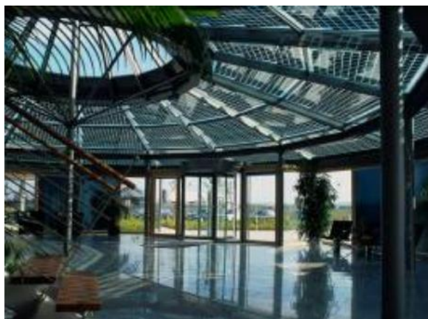
Εικόνα 3.32: Φωτοβολταϊκά που επιτρέπουν τη διέλευση φωτός
