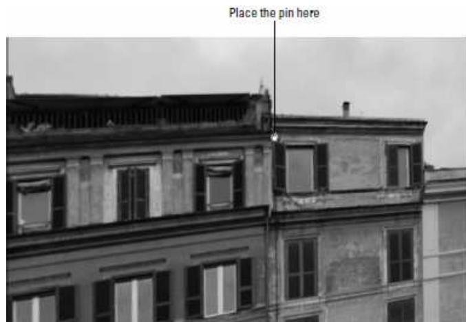
(ΕΙΚΟΝΑ 7: ΤΟΠΟΘΕΤΗΣΗ ΚΑΡΦΙΤΣΑΣ)
