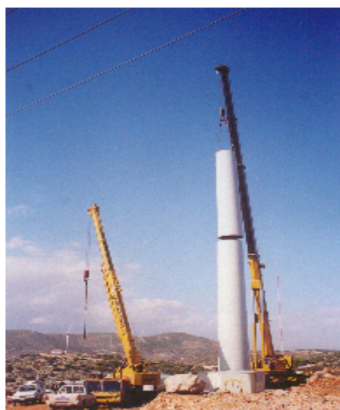
Εικόνα 1.4: Εγκατάσταση πύργου
