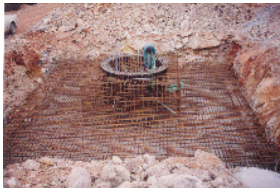
Εικόνα 1.6: Διαδικασία θεμελίωσης ανεμογεννητριών (στάδιο 1)
