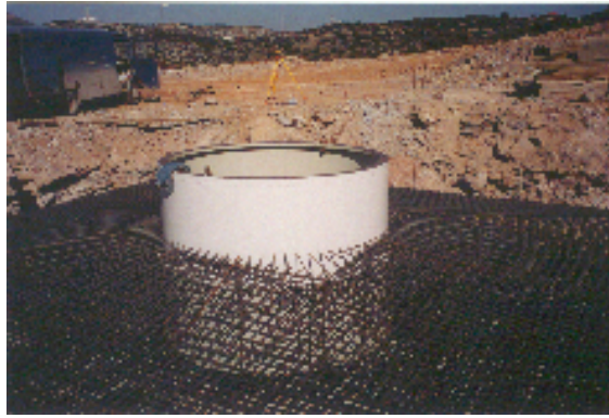
Εικόνα 1.7: Διαδικασία θεμελίωσης ανεμογεννητριών (στάδιο 2)
