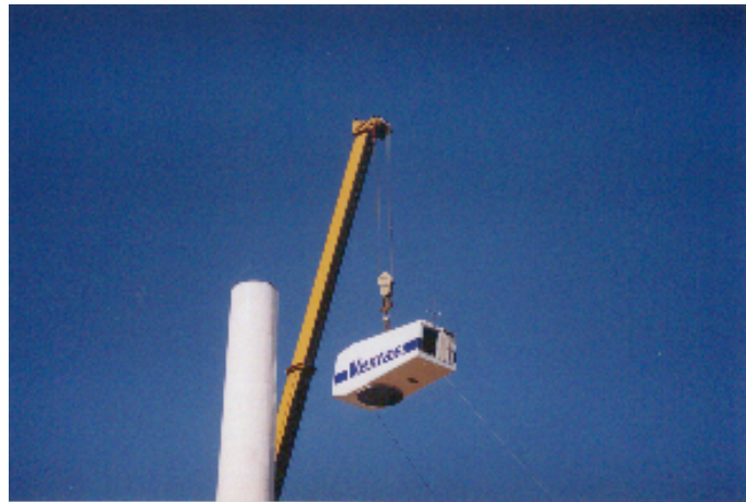
Εικόνα 1.3: Εγκατάσταση ατράκτων στο αιολικό πάρκο CRES
