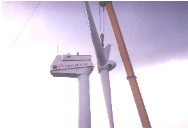
Εικόνα 1.2: Εγκατάσταση ανεμοκινητήρα A/K
