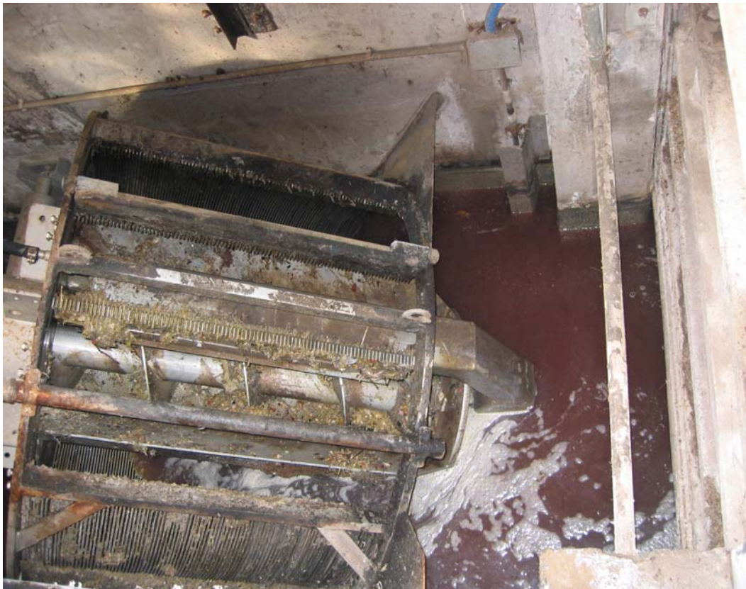
Εικόνα 7.1. : Ψιλή εσχάρα, Μ.Ε.Υ.Α. της Δ.Ε.Υ.Α. Χανίων.
