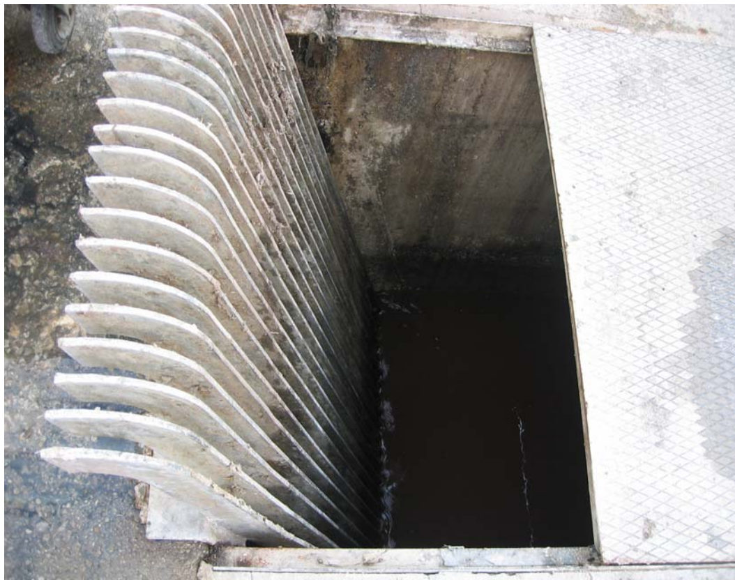
Εικόνα 7.2. : Χοντρή εσχάρα, Μ.Ε.Υ.Α. της Δ.Ε.Υ.Α. Χανίων.
