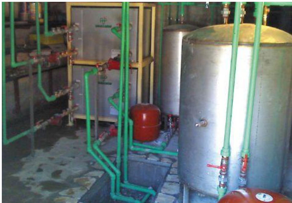
Εικόνα 18 : Μηχανοστάσιο γεωθερμίας
