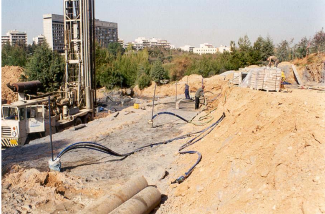
Εικόνα 3 : Γεωθερμική εφαρμογή σε κτήριο του ΕΜΠ, Αθήνα. Διάταξη γεωτρήσεων.
