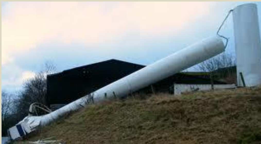
Εικόνα 4. : Πτώση μιας ανεμογεννήτριας
