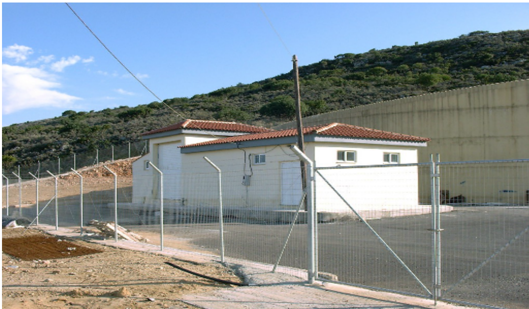
Εικόνα 33. Κτίριο ηλεκτρικών πινάκων δεξ. Βαντέ και χλωρίωσης
