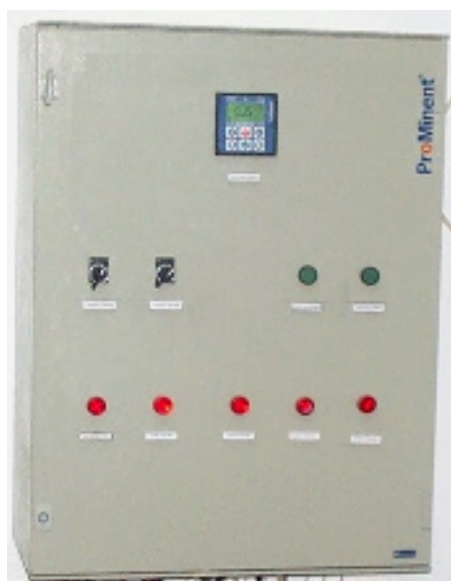
Εικόνα 6. Πίνακας χλωριωτή
