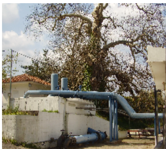
Εικόνα 31. Κτίριο συλλέκτη νερού αντλιοστασίου Αγιάς
