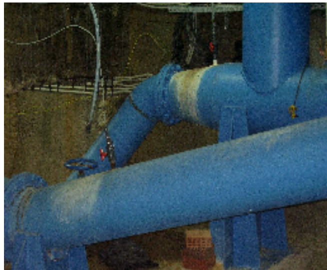
Εικόνα 84. Έγχυση χλωρίου στον αγωγό Φ350(Στην Αγιά).
