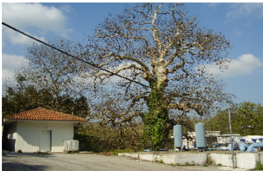
Εικόνα 80.Κτίριο χλωρίωσης Αγυιάς
