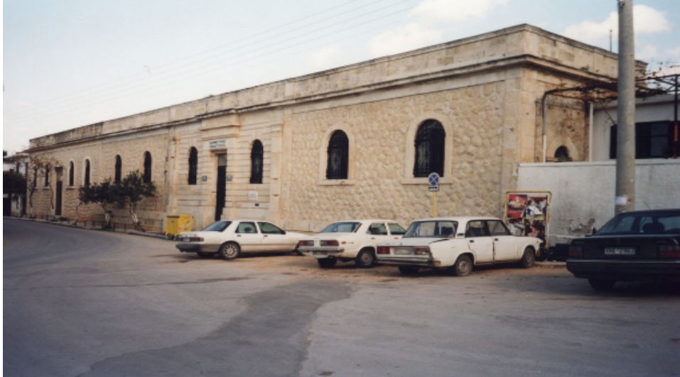
Εικόνα 34. Δεξαμενή Αγίου Ιωάννη (εξωτερικά)
