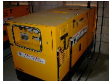
Σχήμα 5α: PV and WEC , Σχήμα 5β: αντιστροφείς «Sunny Island», Σχήμα 5γ: 20 kVA εγκατάσταση γεννητριών πετρελαίου
