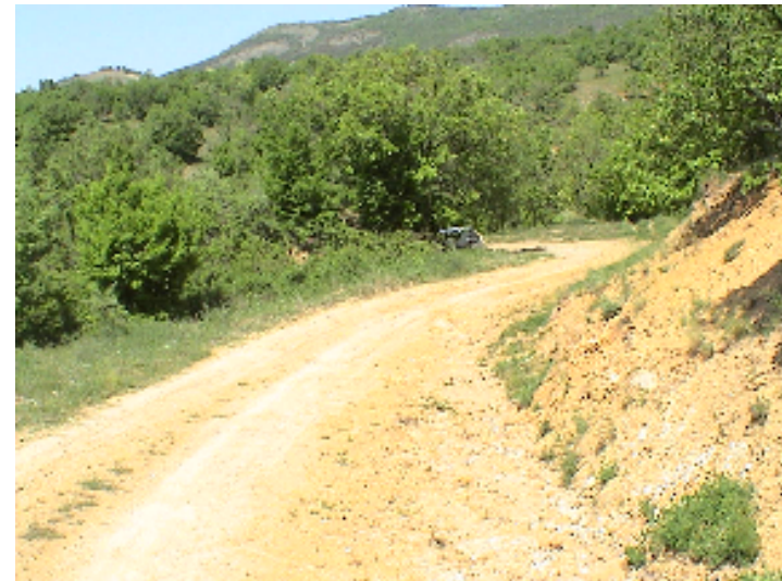
Φώτο 23, 24. Άποψη της θέσεως διόρθωσης της χάραξης στην Χ.Θ. 4+200. Εμφανίζεται το γνευσιακό υπόβαθρο, μαζί με τον ελλουβιακό μανδύα αποσάθρωσης.
