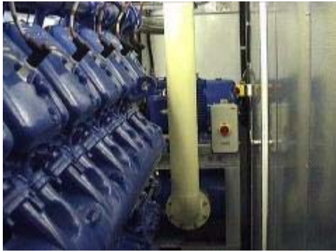
Συναρμολόγηση μηχανών αξιοποίησης Βιοαερίου.
