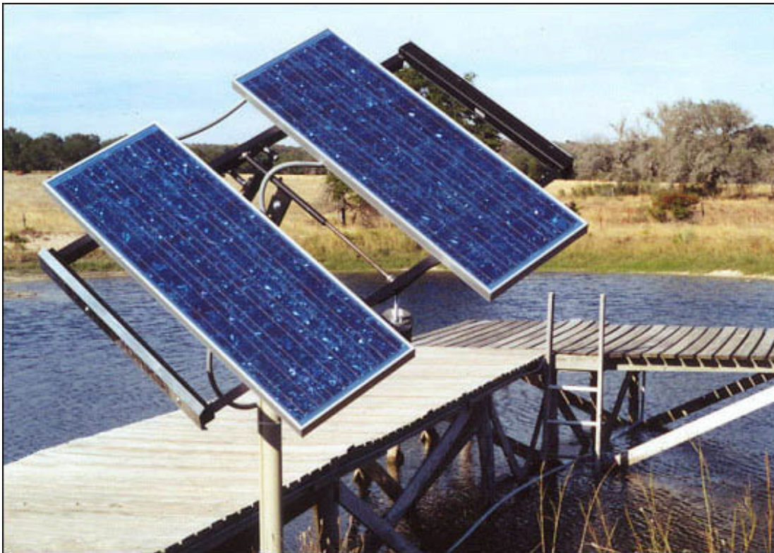
Εικόνα 3.5.α: Tracker με παθητικό σύστημα κίνησης (εμπρόσθια όψη).
