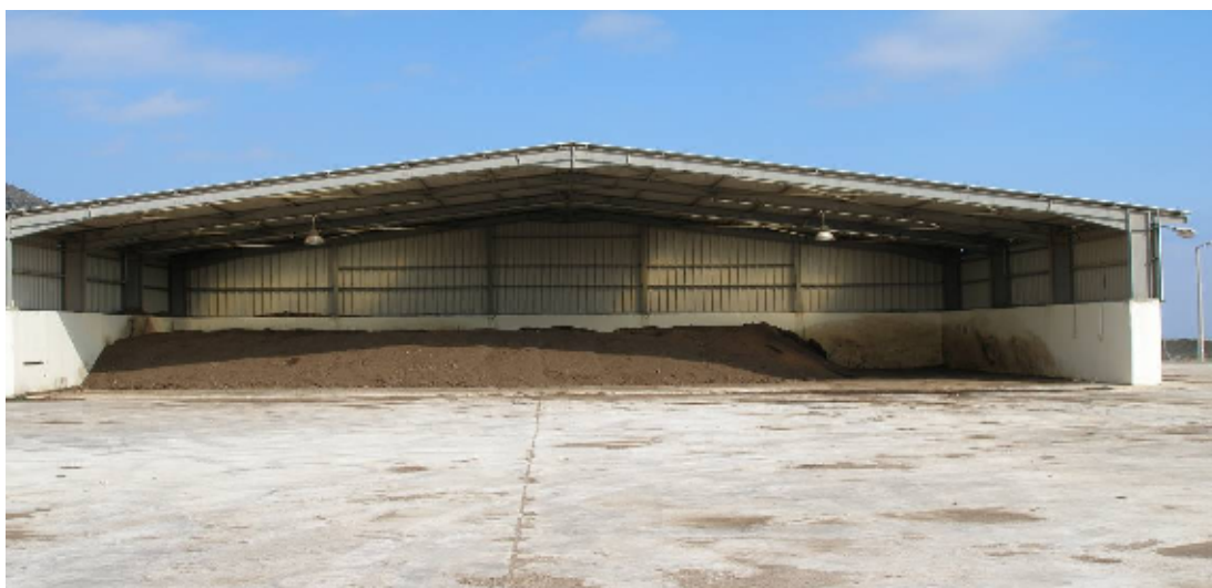
Εικόνα 5.6: Τμήμα αποθήκευσης κομπόστ[33]
