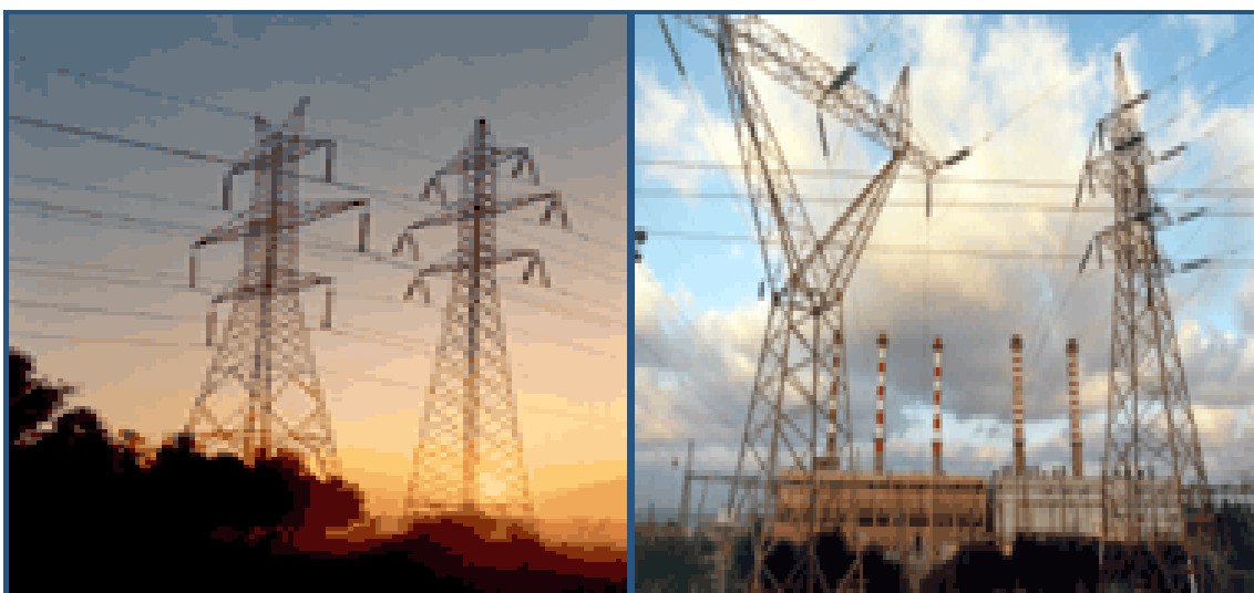
Εικόνα 7: Χαρακτηριστικοί τύποι πύλων ΔΕΗ τύπου πύργος
