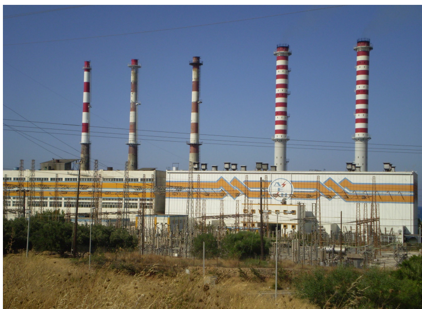
Εικόνα 1: Ο σταθμός παραγωγής στην περιοχή Λινοπεράματα.
