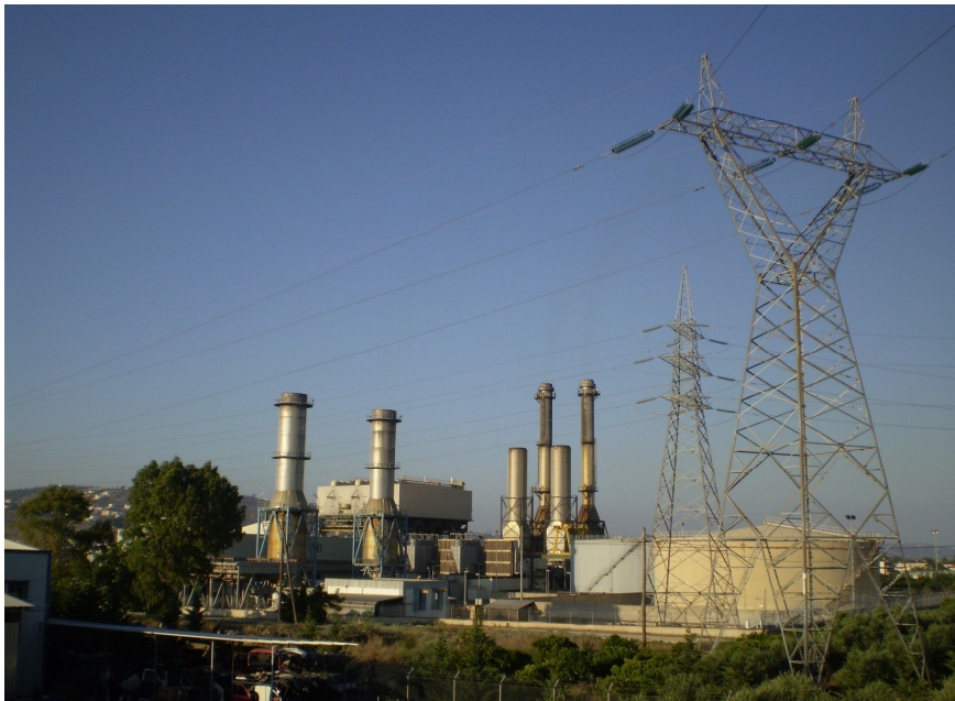
Εικόνα 2: Ο σταθμός παραγωγής στην περιοχή Ξυλοκαμάρια.
