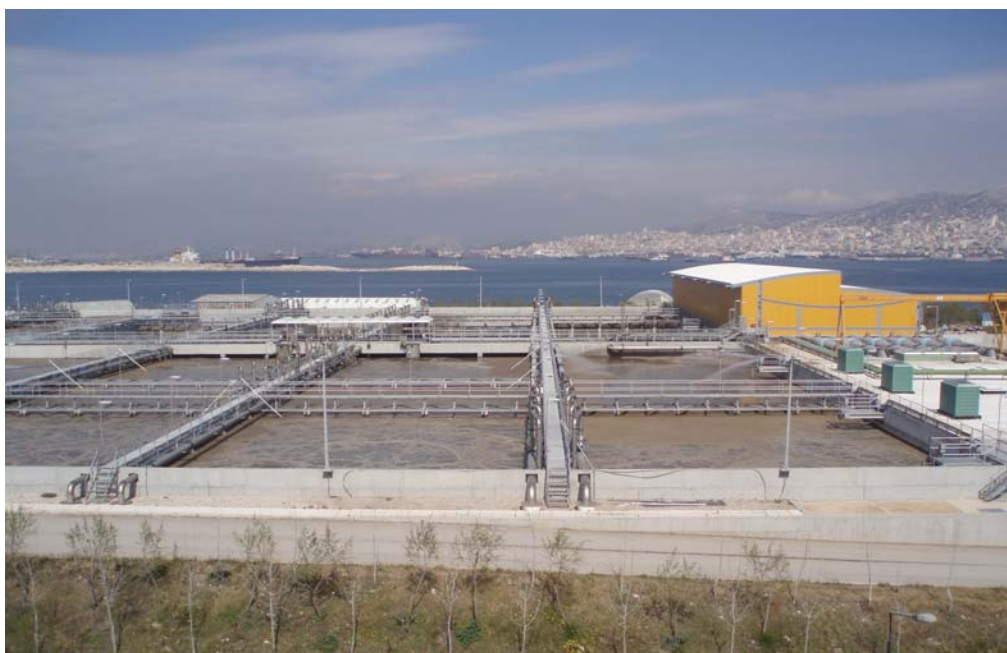
Εικόνα 1.4: Απεικόνιση Δεξαμενών Αερισμού (Βιοαντιδραστήρες)
