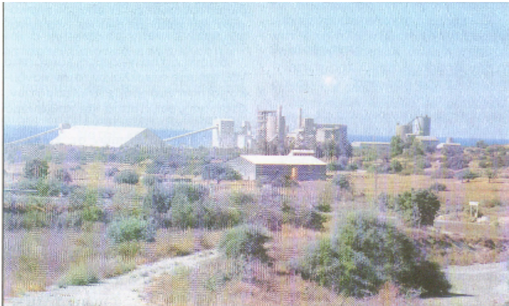
Σχήμα 5.2 Εργοστάσιο παραγωγής τσιμέντου. Οι πρώτες ύλες προέρχονται από τα γεωλογικά στρώματα της Κύπρου
