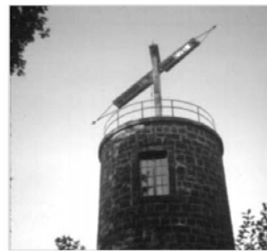
Σταθμός αποστολής-λήψης μηνυμάτων του οπτικού τηλεγράφου του Chappe.
