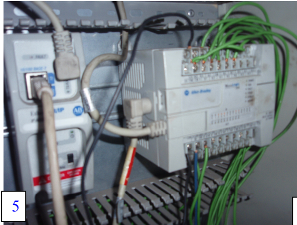
6.5.3 Expansion module για σύνδεση σε σύστημα SCADA και σχεδιάγραμμα υλοποίησης συστήματος SCADA.
