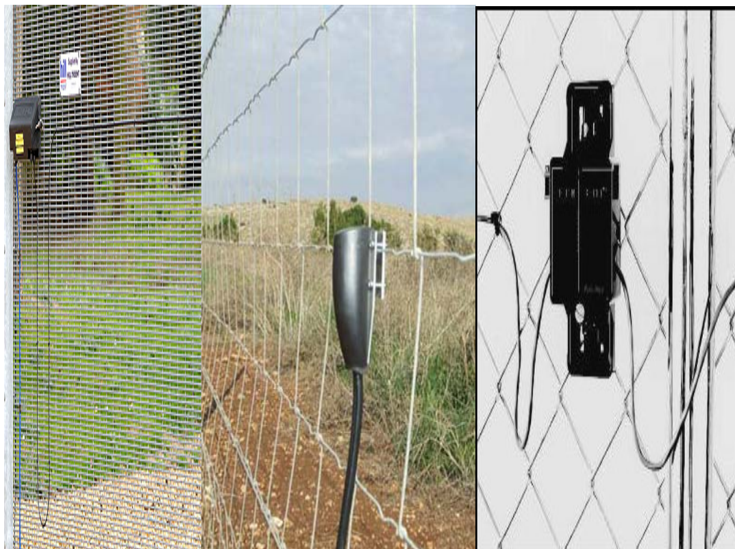
Εικόνα 278: Αισθητήρες δόνησης σε φράκτη
