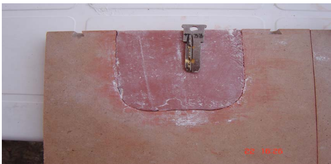
Εικόνα 118: Τοποθέτηση κλειδιού στο καλούπι
