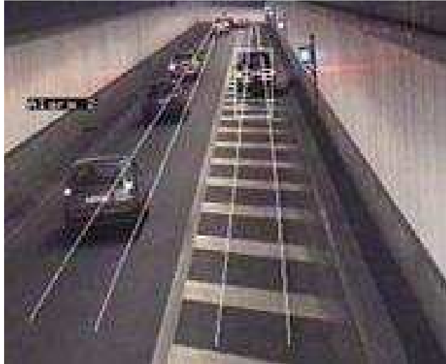
Εικόνα 9. Ανίχνευση σταματημένου οχήματος σε σήραγγα
