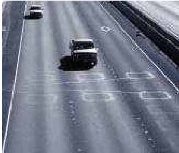
Εικόνα 1. Ζεύγη μαγνητικών ανιχνευτών βρόχου
