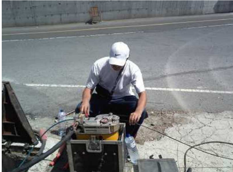
Εικόνα 91 : Χρήση του breeze κατά τη διάρκεια φυσήματος καλωδίου
