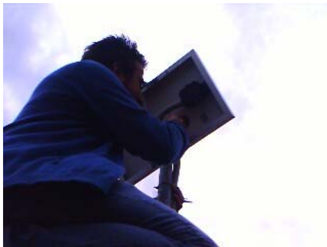
Εικόνα 4.5: κατά την προσαρμογή της κεραίας στην πίσω όψη του φωτοβολταϊκού στοιχείου.
