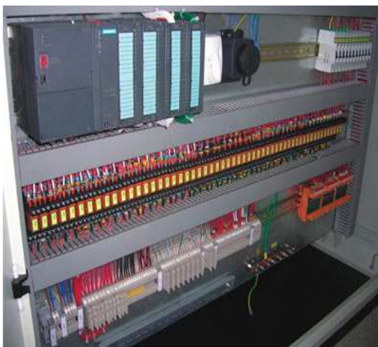
Εικόνα 6 Πίνακας ελέγχου και καλωδιώσεις Α/Γ
