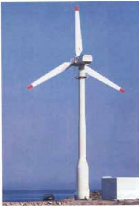
Εικόνα 5 Α/Γ με σωληνωτό πύργο και με δικτυωτό πύργο αντίστοιχα [12].
