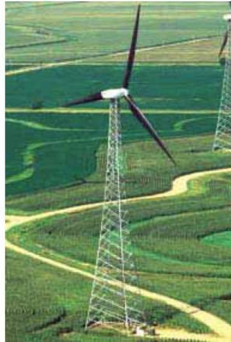
Εικόνα 5 Α/Γ με σωληνωτό πύργο και με δικτυωτό πύργο αντίστοιχα [12].
