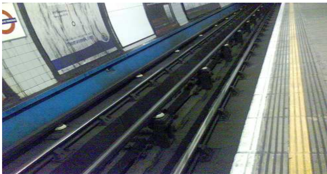
Φωτ. 7 Σύστημα 4 ης γραμμής
