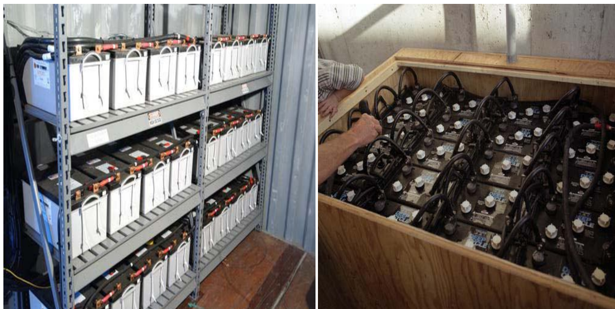
Σχήμα 4.4.1.37: Συστοιχίες μπαταριών από φωτοβολταϊκά συστήματα.
