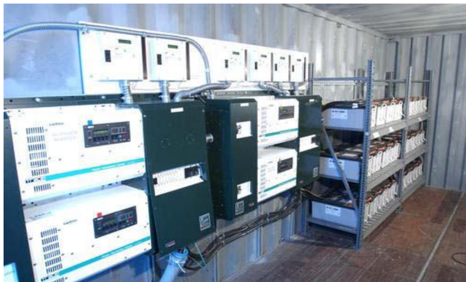
Εικόνα 4.3.2.7.35: Τοποθέτηση του κέντρου ελέγχου και της συστοιχίας μπαταριών σε κοντέινερ.
