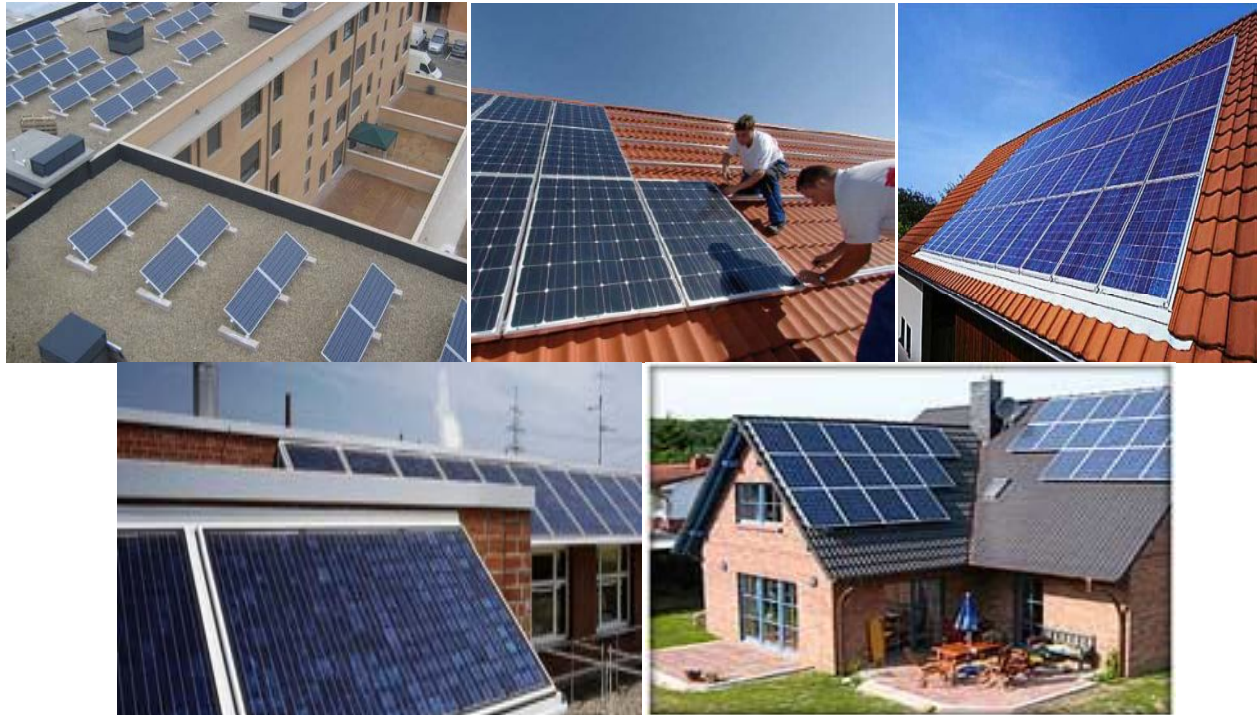
Εικόνες 7.9.10: Φωτοβολταϊκά σε στέγες κτηρίων
