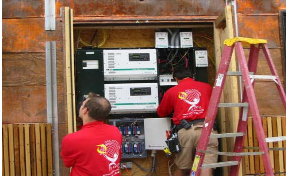
Εικόνα 4.3.2.7.34: Εγκατάσταση κέντρου ελέγχου σε ένα φωτοβολταϊκό σύστημα.
