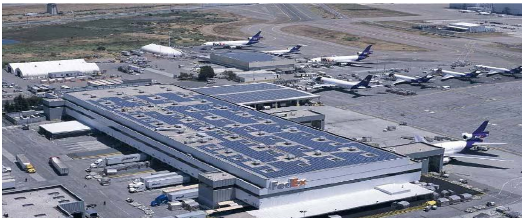
Σχήμα 3.2.25: Φωτοβολταϊκά ισχύος 900 KWp στο αεροδρόμιο του Oakland στην Καλιφόρνια
