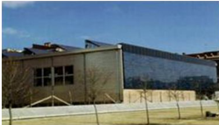
Εικόνα 2.5.3.1.39: Φωτοβολταϊκά ενσωματωμένα σε κτίρια
