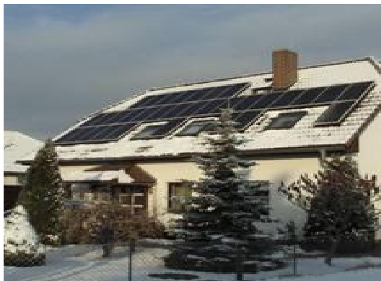
Εικόνα 2.5.3.1.40: Φωτοβολταϊκά ενσωματωμένα σε κτίρια
