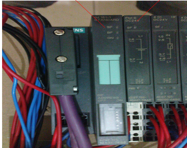
Εικόνα 1.1.2.7.2.1 : Interface Module/ Power Module
