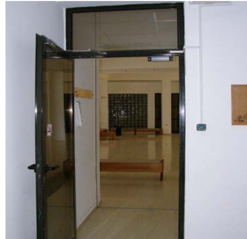
Εικόνα 5.3 Μπουτόν για την έξοδο και ηλεκτρομαγνήτης
