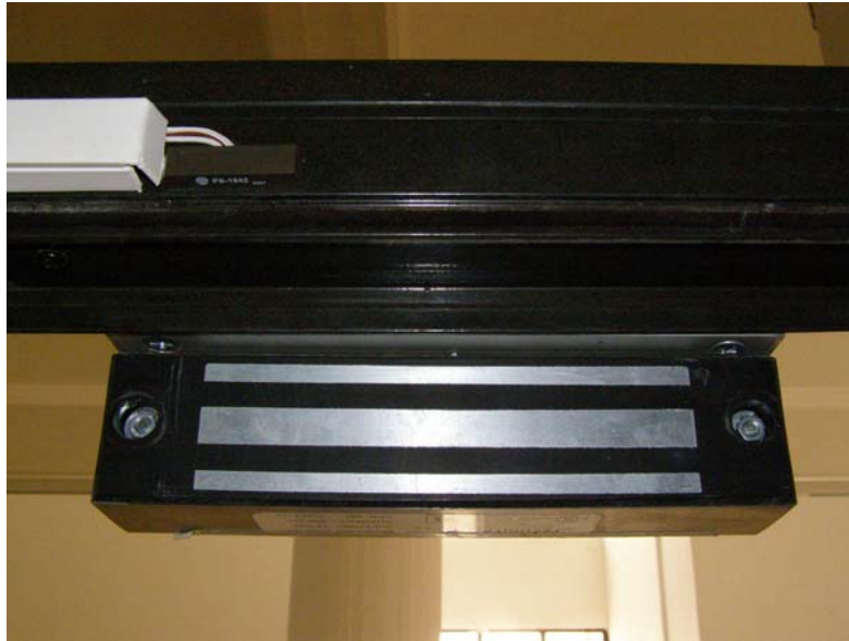
Εικόνα 4.16 Ηλεκτρομαγνήτης(σταθερό μέρος)
