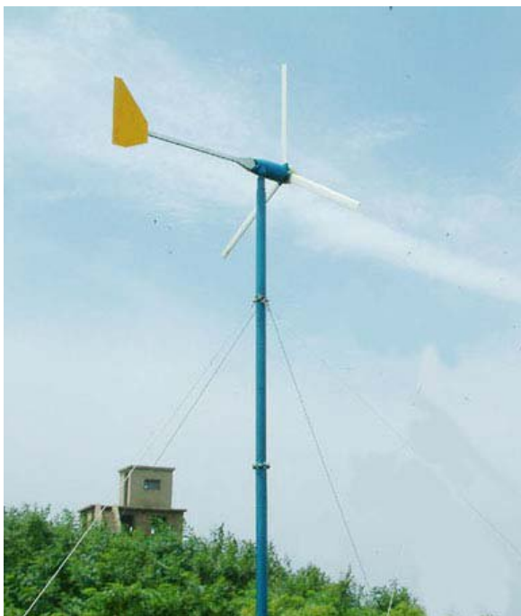
Σχ. 5.1 Α/Γ 1 kW που θα χρησιμοποιηθεί στο Υ/Σ
