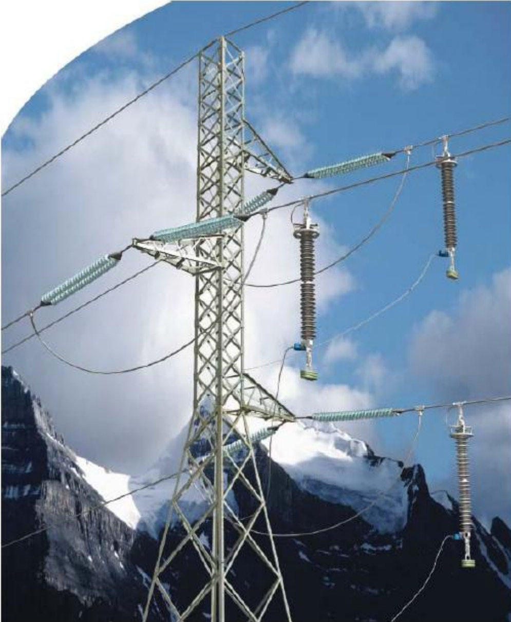
Σχήμα 1: Αλεξικέρανα σε γραμμή μεταφοράς
