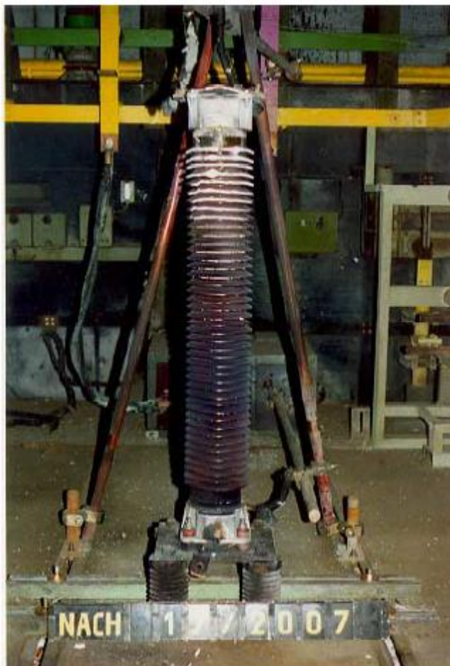
Σχήμα 22: Πορσελάνη στεγάζεται σταματών μετά από πίεση Δοκιμή ανακούφισης με ονομαστικό ρεύμα βραχυκυκλώματος (63 kA, 200 ms). Με εξαίρεση κάποια υπόστεγα που έσπασαν το περίβλημα παρέμεινε άθικτο.
