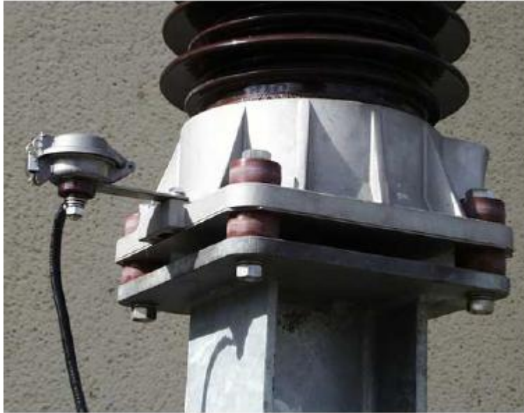
Σχήμα. 13: Κάτω φλάντζα με μονωτικά πόδια και την παρακολούθηση χάσμα σπινθήρων
