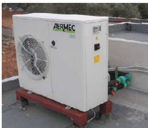
Εικόνα 8: Αντλία θερμότητας αέρα/νερού
