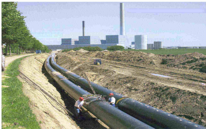
Εικόνα 15: Κατασκευή δικτύου διανομής T/Θ στις επεκτάσεις του σχεδίου πόλης της Κοζάνης
