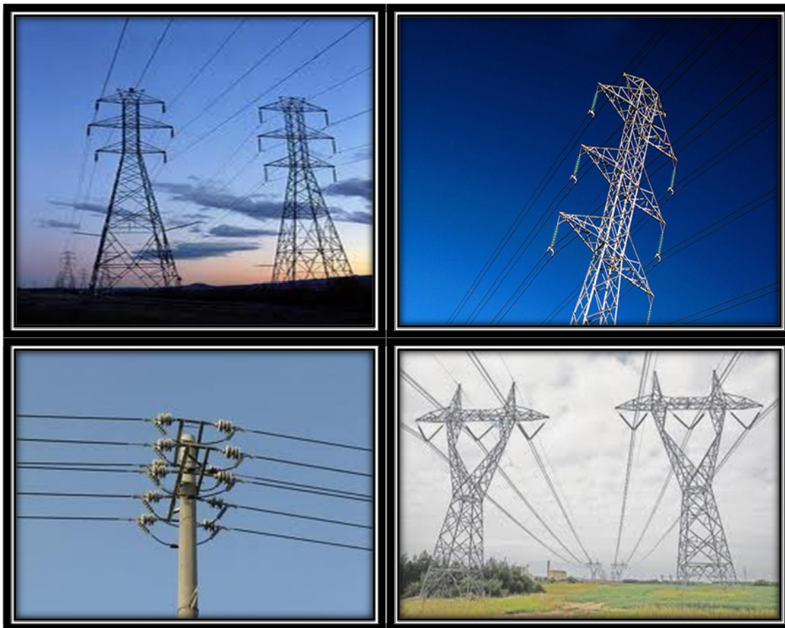
Εικ. 1.1. Γραμμές διανομής (κάτω αριστερά) μέσης τάσης και μεταφοράς υψηλής τάσης.
