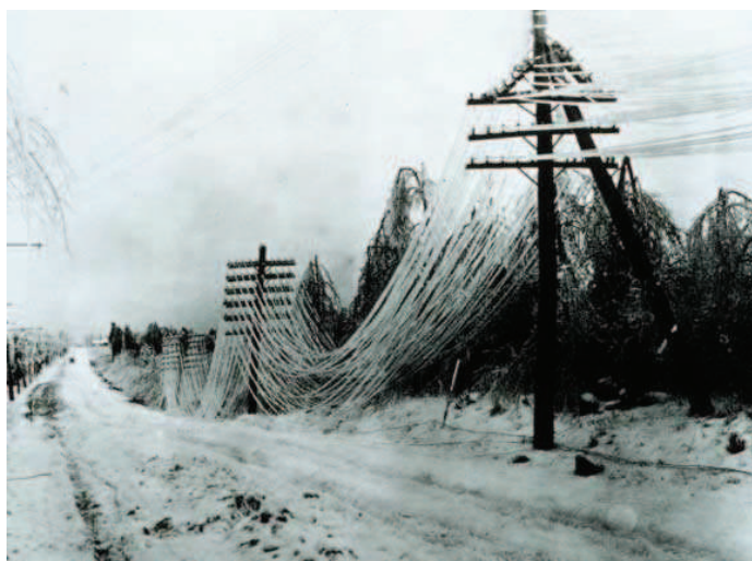
Επικάθηση πάγου σε γραμμή μεταφοράς με συνέπεια να λυγίσει υπό το βάρος του πάγου
