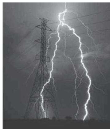
Κεραυνικό πλήγμα σε γραμμή μεταφοράς 2
