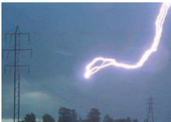
Κεραυνικό πλήγμα σε γραμμή μεταφοράς 1
