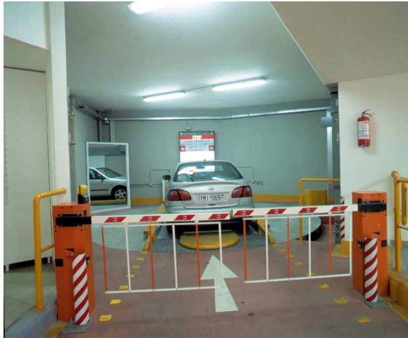
Εικόνα 6: Τρόπος τοποθέτησης του οχήματος στο χώρο υποδοχής
