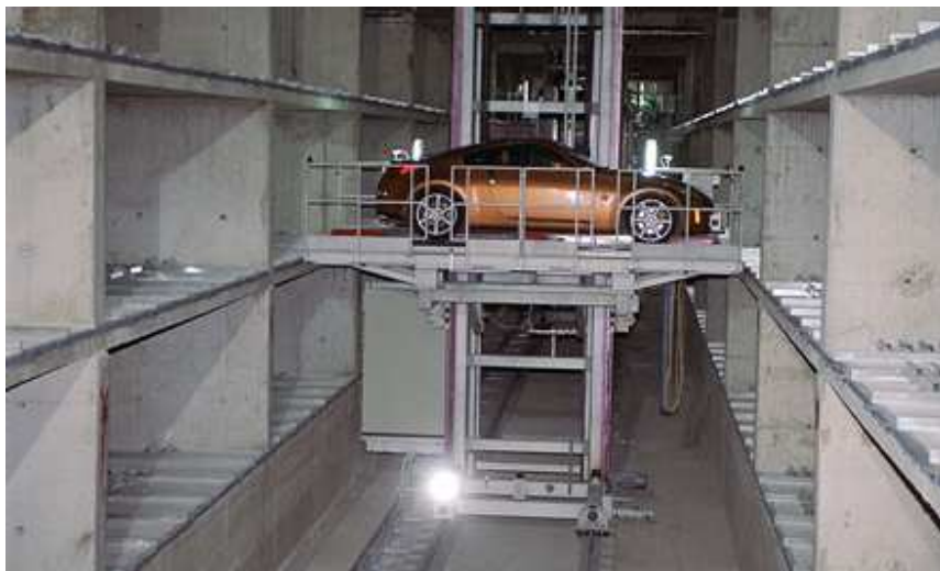
Εικόνα 12: Τρόπος τοποθέτησης αυτοκινήτων σε σταθμό αυτομάτου συστήματος στάθμευσης
