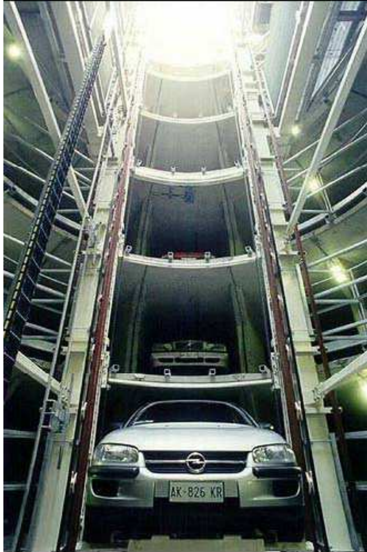
Εικόνα 3: Τρόπος στάθμευσης οχημάτων στον υπόγειο σταθμό αυτοκινήτων της Cesena
