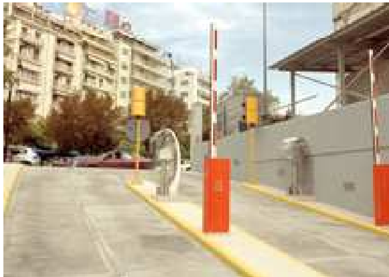
Εικόνα 16: Είσοδος σε σταθμό στάθμευσης αυτοκινήτων με αυτόματο σύστημα
