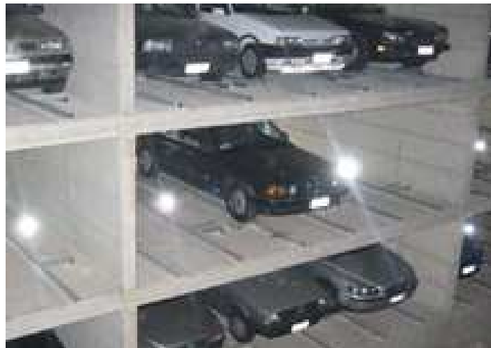
Εικόνα 13: Εναλλακτικός τρόπος τοποθέτησης αυτοκινήτων σε σταθμό αυτομάτου συστήματος στάθμευσης
