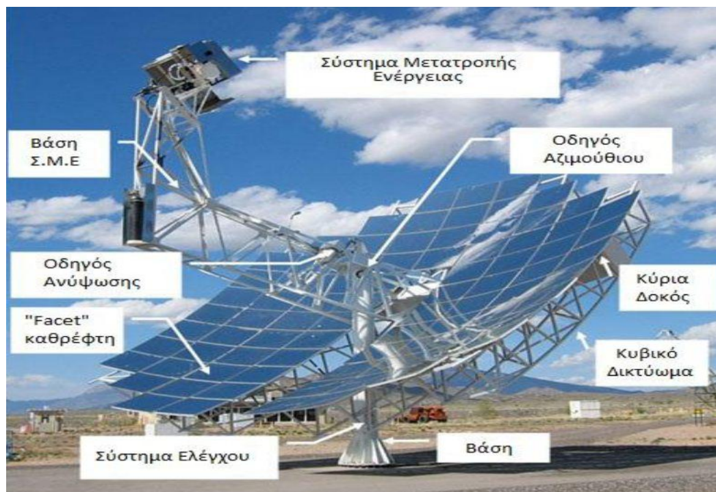
Εικ. 4.20 Επιμέρους μέρη του Suncatcher.
