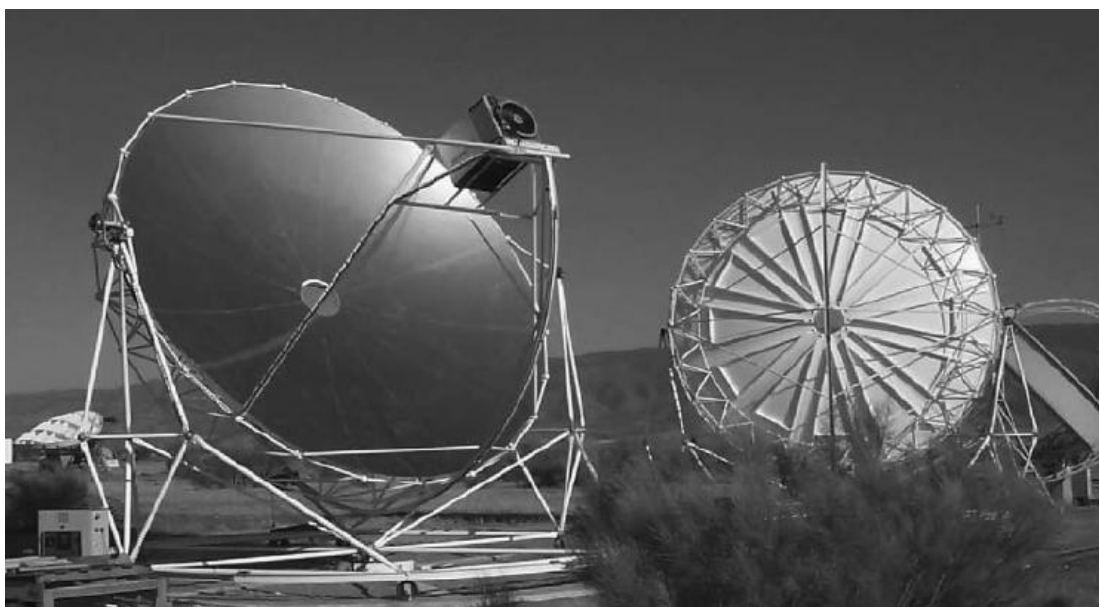
Εικ. 4.18 Σύστημα δίσκου μηχανής Eurodish ισχύος 10 kW e στην Ισπανία.
