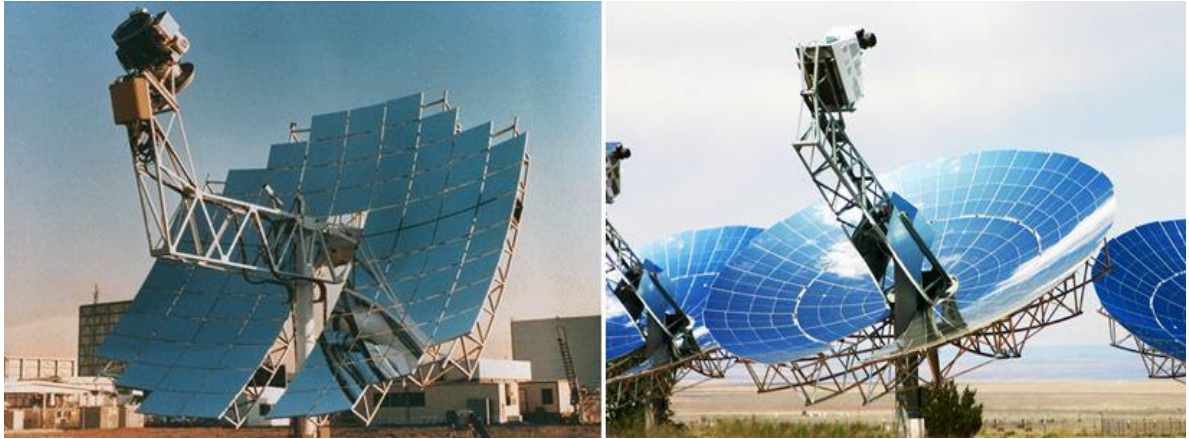
Εικ. 4.1 Συστήματα δίσκου μηχανής με τετράγωνα (α) και κυκλικά (β) κάτοπτρα.
