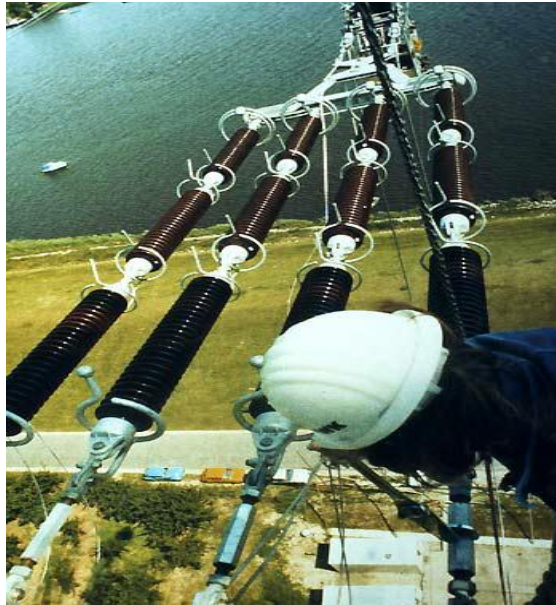
Εικόνα 1.6.6 : Μονωτήρας τύπου longrod από πορσελάνη
