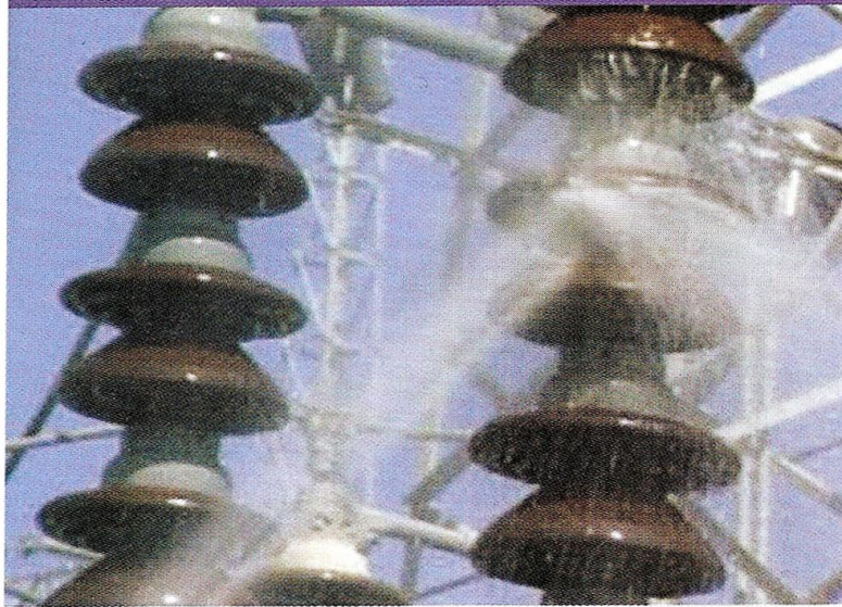
Εικόνα 2.3.3.1.1 : Πλύσιμο υποσταθμού 150KV με νερό υπό υψηλή πίεση
