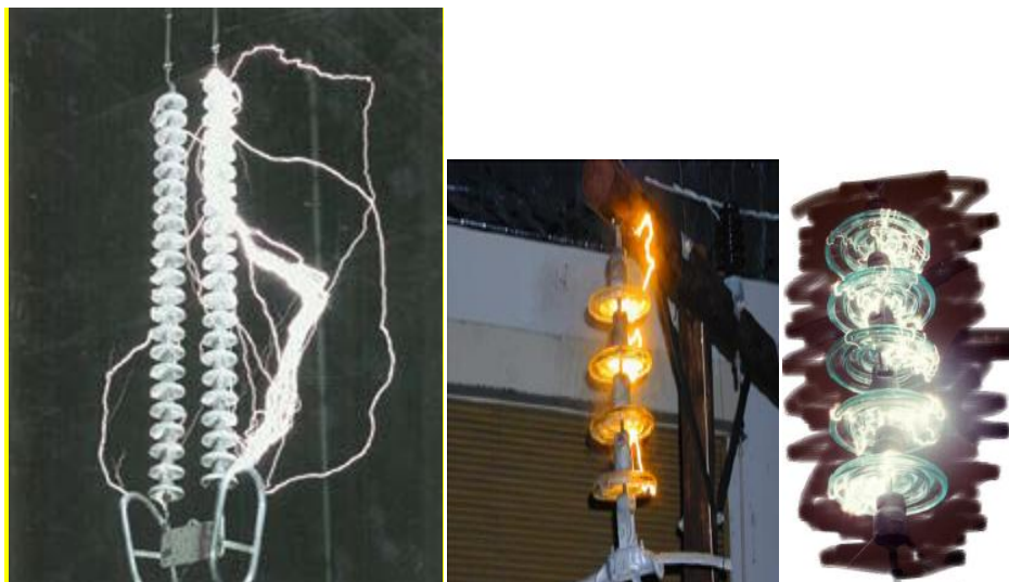
Εικόνα 1.8.1 : το φαινόμενο της υπερπήδησης των μονωτήρων
