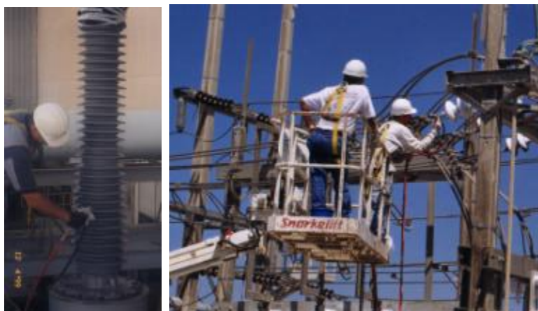
Εικόνα3.3.1.: Εκπαιδευμένο προσωπικό για την επικάλυψη με εφαρμογή του ψεκασμού.
