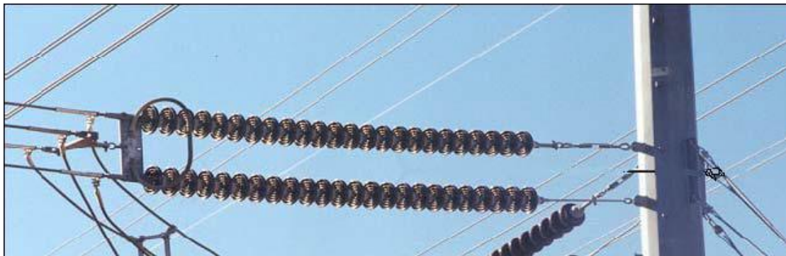
Εικόνα 2.6.1: Κεραμικοί μονωτήρες σε εναέρια γραμμή.
