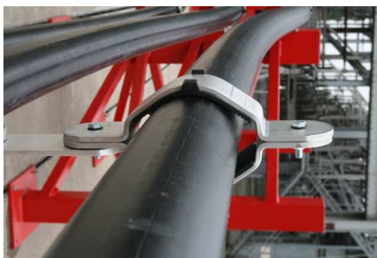
Μονωμένος αγωγός υψηλής τάσης αντοχής 150.000 V
