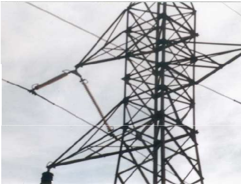
Σχήμα 2.9 Τοποθέτηση μονωτήρων από Teflon σε διάταξη Λ, στην Γραμμή 150kV Λινοπεράματα-Ιεράπετρα
