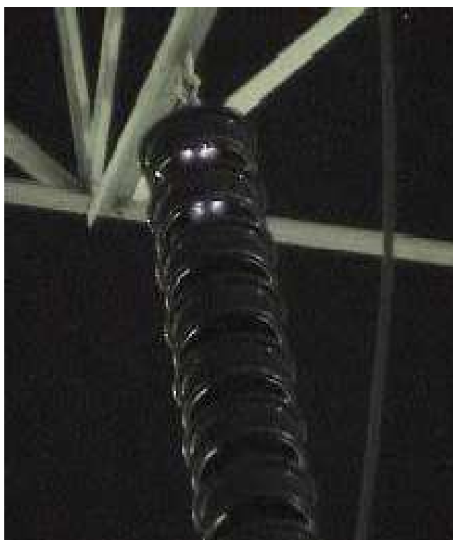
Σχήμα 2.1 Ηλεκτρική διάσπαση ξηρών ζωνών σε μονωτήρες πορσελάνης
