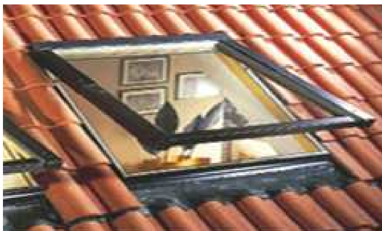
Σχήμα 3.6 Ανακλινόμενο παράθυρο στέγης [42]
