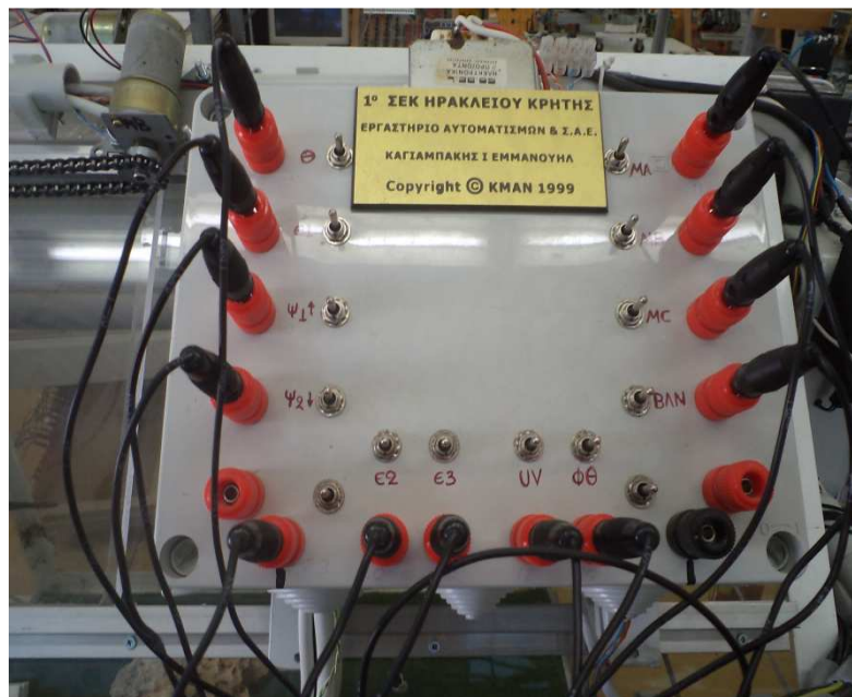
14: Πίνακας Ελεγχου Κατασκευής.
