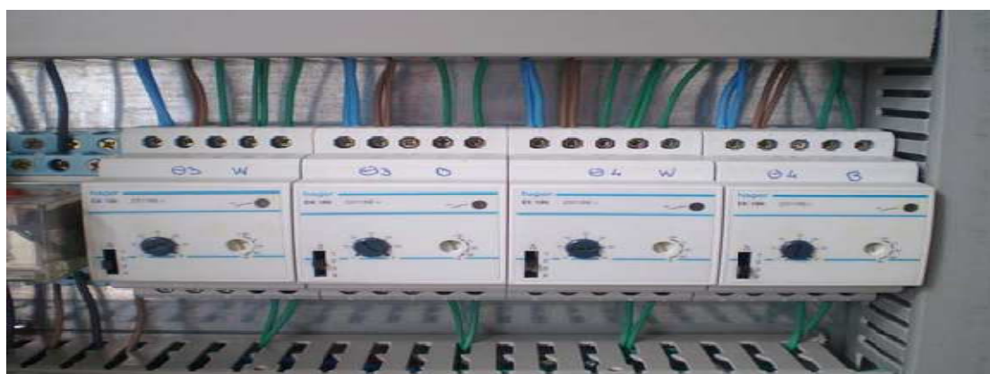
στ3: αναλογικός ελεγκτής θερμοκρασίας με ξεχωριστό αισθητήρα.
