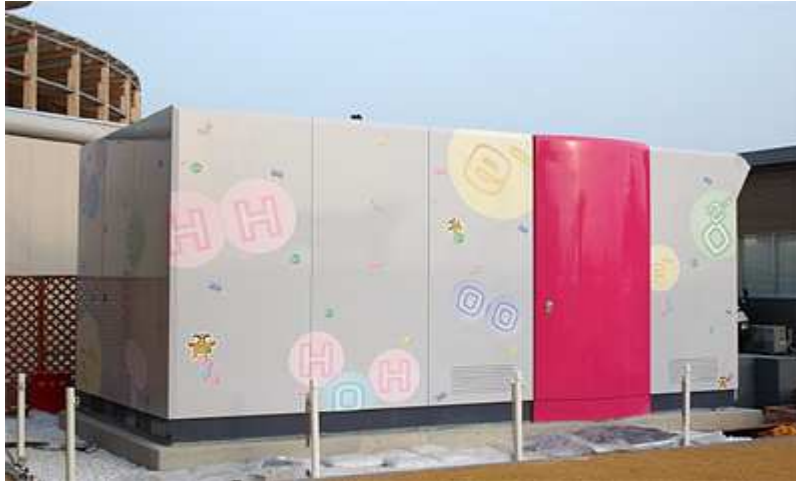
Σχήμα 4.17: Mitsubishi Heavy Industries εξωτερικό σύστημα SOFC συμπαραγωγή στο Aichi Παγκόσμια Έκθεση[78]
