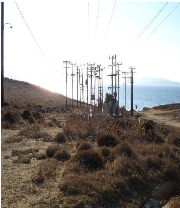
Εικόνα 2.3(Ζεύξη υποβρύχιων με εναέριες γραμμές, πηγή Panoramio)
