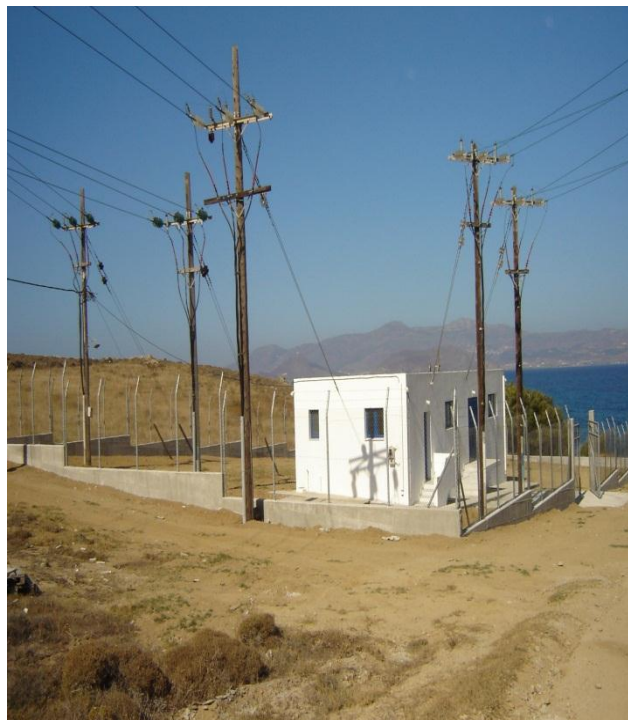
Εικόνα 2.4(Ο Σταθμός ζεύξης των υποβρύχιων) με εναέριων γραμμών, πηγή από προσωπική έρευνα)
