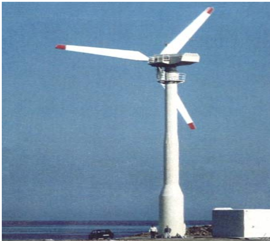
ΟΑ /100 (Οριζοντίου άξονα 100kW) Σχεδίαση: Ν. Αθανασιάδης, Γ. Μπεργελές, Κ. Μιχαηλίδης Κατασκευή: ΒΙΟΚΑΤ ΑΤΒΕ, 1990-1991 Εγκατάσταση: 1991, Σκύρος
