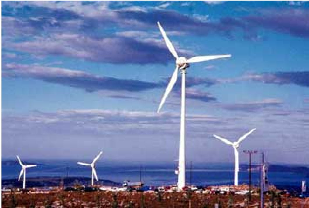
Εικόνα:2 Αιολικό Πάρκο
