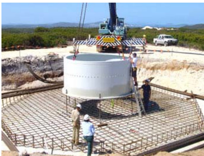
Εικ. 5.2 Οπλισμός βάσης της ανεμογεννήτριας .
