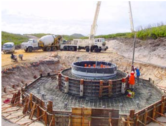
Εικ. 5.1 Κατασκευή θεμελίων.
