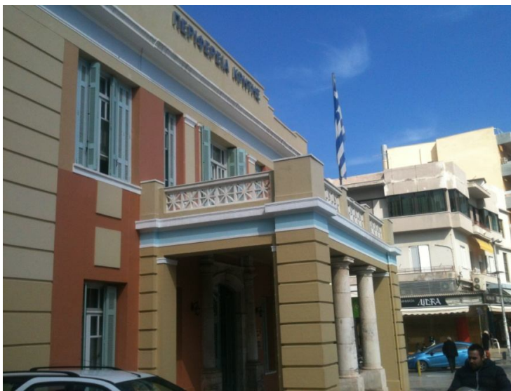
Σχήμα 4.7: Τη Νότια και Νοτιοανατολική άποψη του κτιρίου (Πηγή: Ο συγγραφέας).
