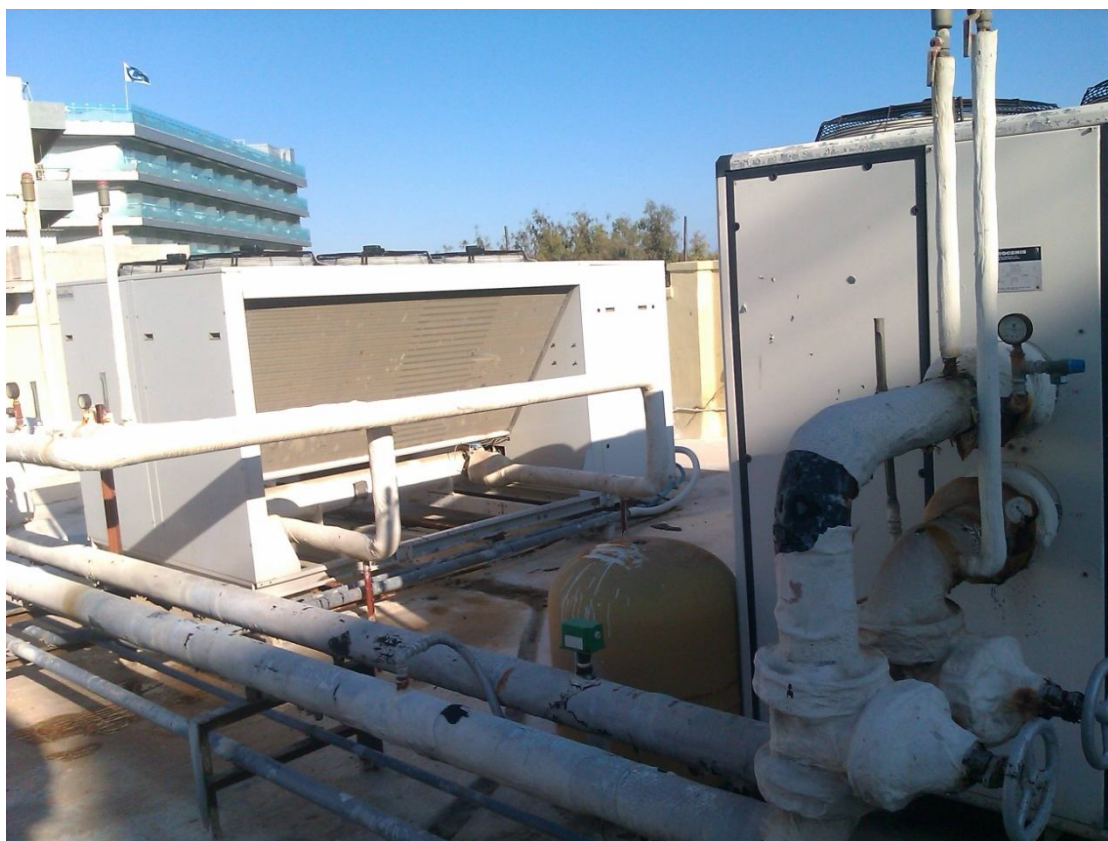
Σχήμα 4.10 . : Κεντρική αερόψυκτη αντλία θερμότητας (Πηγή: Ο συγγραφέας).
