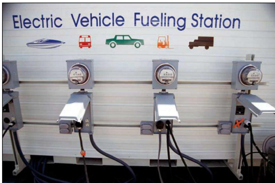
Σχήμα 5.5 Ένας ήδη υπάρχων σταθμός ανεφοδιασμού οχημάτων με ηλεκτρική ενέργεια
