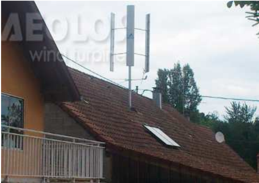
Εικόνα 3.1: Εγκατάσταση ανεμογεννήτριας ΑΕΟΛΟΣ 1KW σε κτίριο [58]
