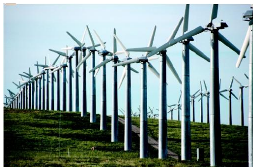
Εικόνα 1.4 : Επίγειο αιολικό πάρκο.
